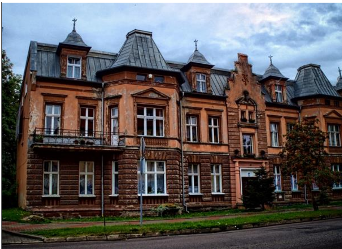
Rysunek 18. Budynek przy ulicy Kolejowej 29 w Olecku
