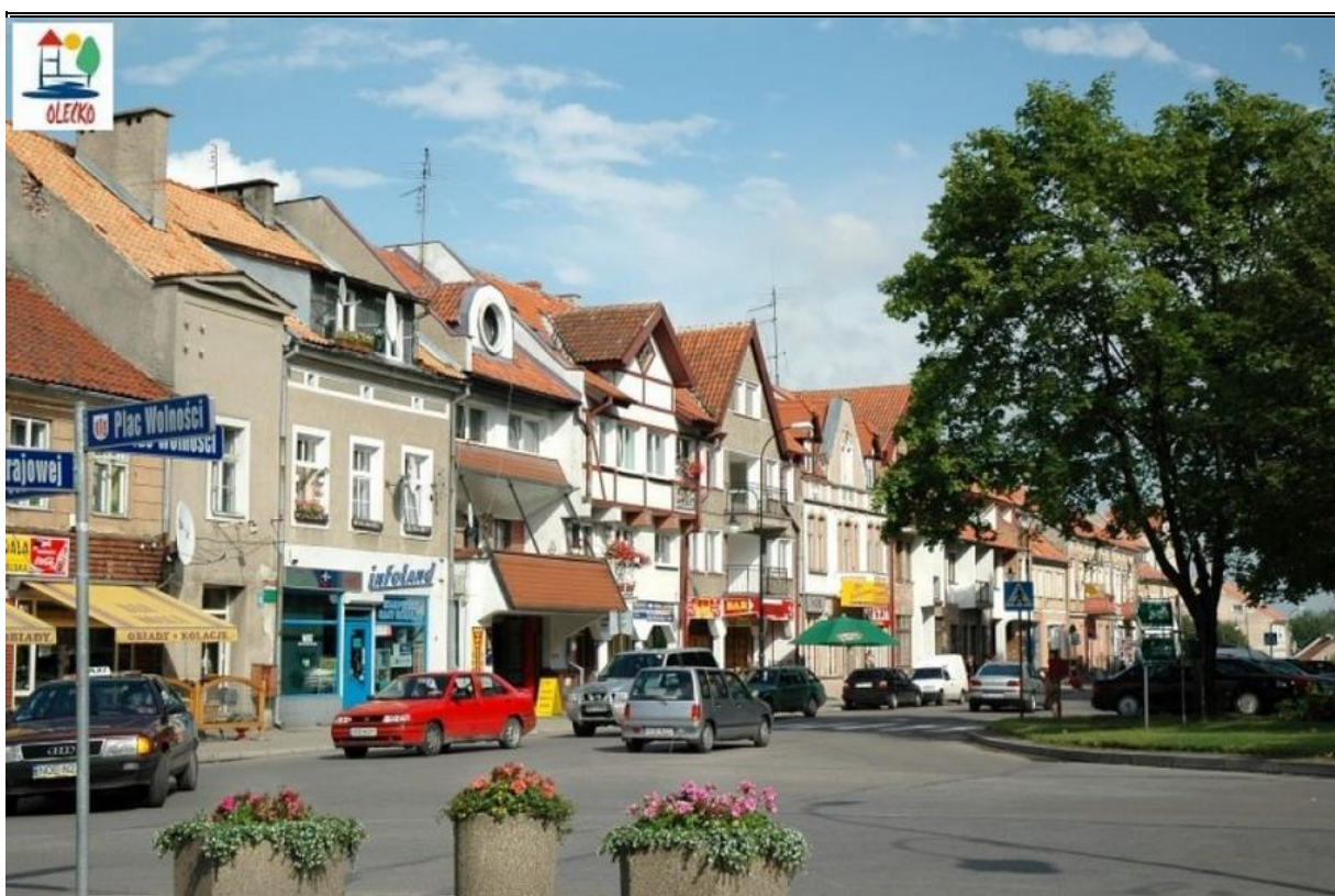
Fotografia 13. Zabudowa przy Placu Wolności w Olecku
